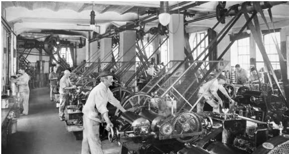
Der Buntfarben-Anreissaal mit riemenbetriebenen Maschinen zum Mischen der Farben. (Foto um 1930)
