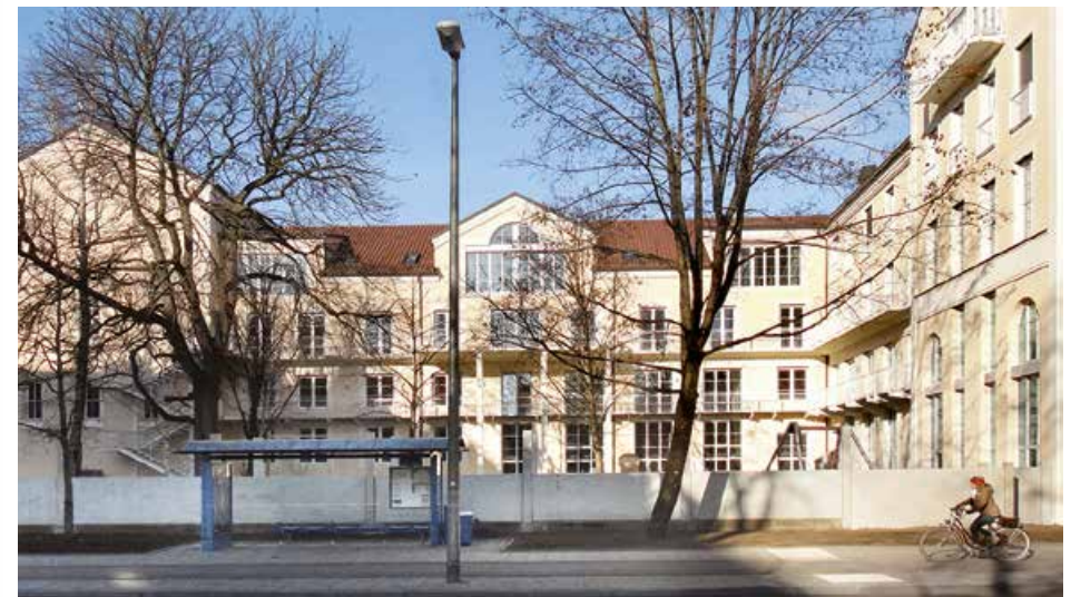
Neubau im Jahr 2016 einer "Casa Don Bosco" auf dem Gelände der ehemaligen Kreisirrenanstalt
