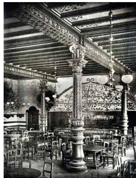
Für die Innenausstattung der Gaststätte Franziskanerkeller fertigte die renommierte Eisengießerei F.S. Kustermann die kunstvoll verzierten, gusseisernen Säulen und Deckenträger an.
