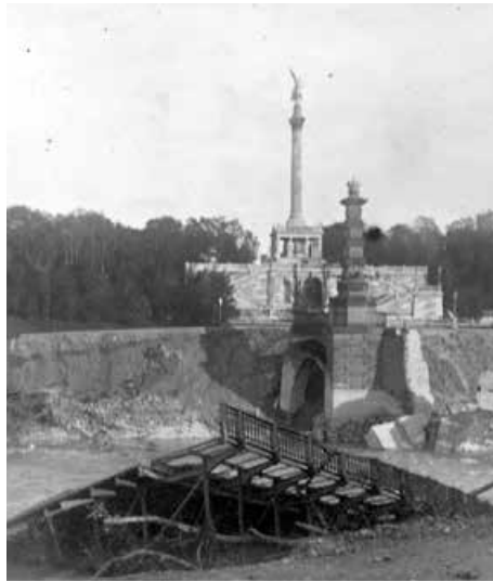
Blick nach Osten auf die Reste der am 14. 9. 1899 in die Isar gestürzten Luitpoldbrücke
