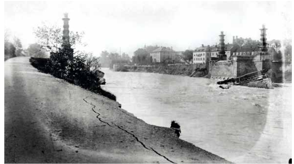
Blick nach Westen einen Tag nach dem Einsturz: Die Luitpoldbrücke ist komplett in den Fluten der Isar versunken. (Foto vom 15. 9. 1899)
