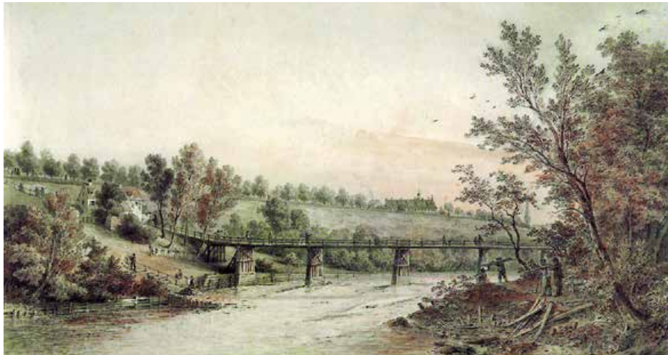
Der hölzerne "Röhrensteg" über die Kleine Isar zur Praterinsel war Teil der Wasserleitung vom Haidhauser Brunnhaus in die Münchner Residenz. Aquarell 1869 von C. A. Lebschée (1800-1877)
