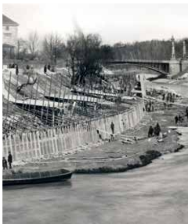
Uferbauarbeiten 1893 an der Widenmayerstraße, im Hintergrund die stählerne Luitpoldbrücke
