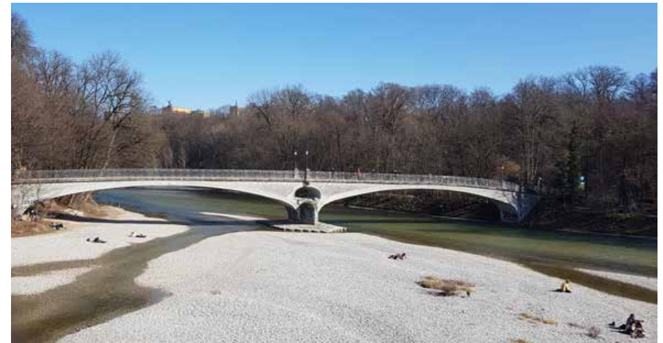
Für die Verlegung von Stromleitungen von Münchens erstem Elektrizitätswerk, dem Muffat Werk, wurde 1898 der attraktiv im Jugendstil gestaltete Kabelsteg gebaut, der Haidhausen mit der Praterinsel verband.
