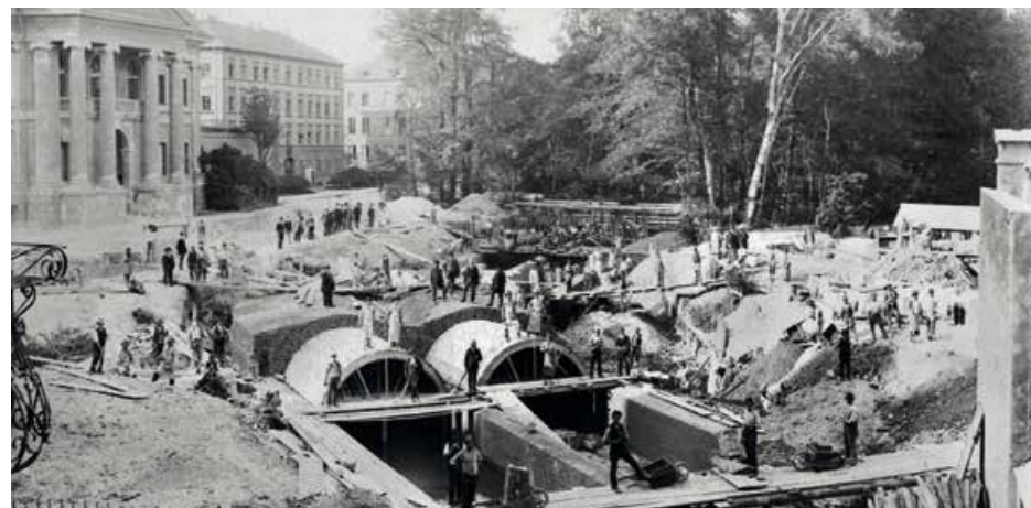
Beim Bau der Prinzregentenstraße mussten einige Bäche aufwendig überbrückt werden, wie hier der Eisbach vor dem Prinz-Carl-Palais. (Foto aus dem Jahr 1890)
