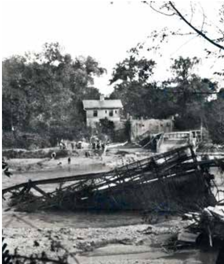
Die Eisenfachwerkbrücke in Bogenhausen wurde am 13. 9. 1899 durch Hochwasser total zerstört.
