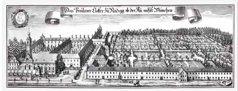
Das große Paulaner Kloster nach dem Neubau der Anlage 1660/65, links mit der Kirche St. Borromäus, rechts der Klostergarten mit einem Bau für 34 Wohnungen davor. (Kupferstich von Michael Wening, um 1700)
