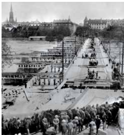
Um Platz für die neue Brücke zu schaffen, wird 1902 die alte Reichenbachbrücke verschoben.
