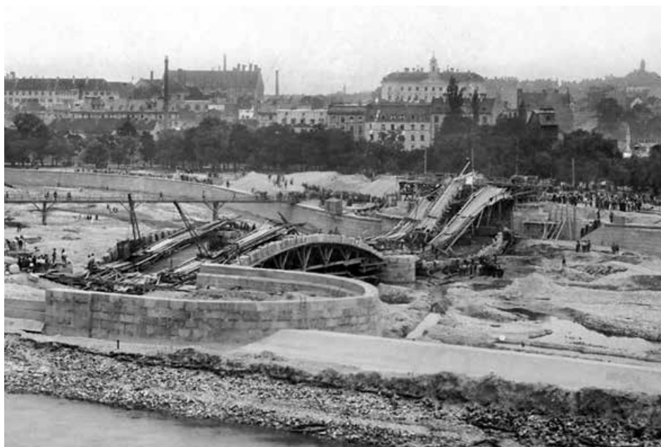
Beim Bau der Corneliusbrücke 1902 stürzt auf der Auer Seite einer der Brückenbögen ein.
