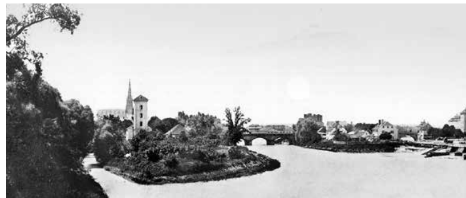
Brunnhaus mit Wasserturm auf der Kalkofeninsel. Mariahilfkirche im Hintergrund. Fotoaufnahme aus dem Jahr 1865.
